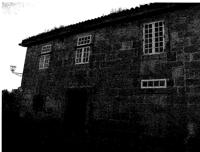
Tramo izquierdo de la fachada principal.
