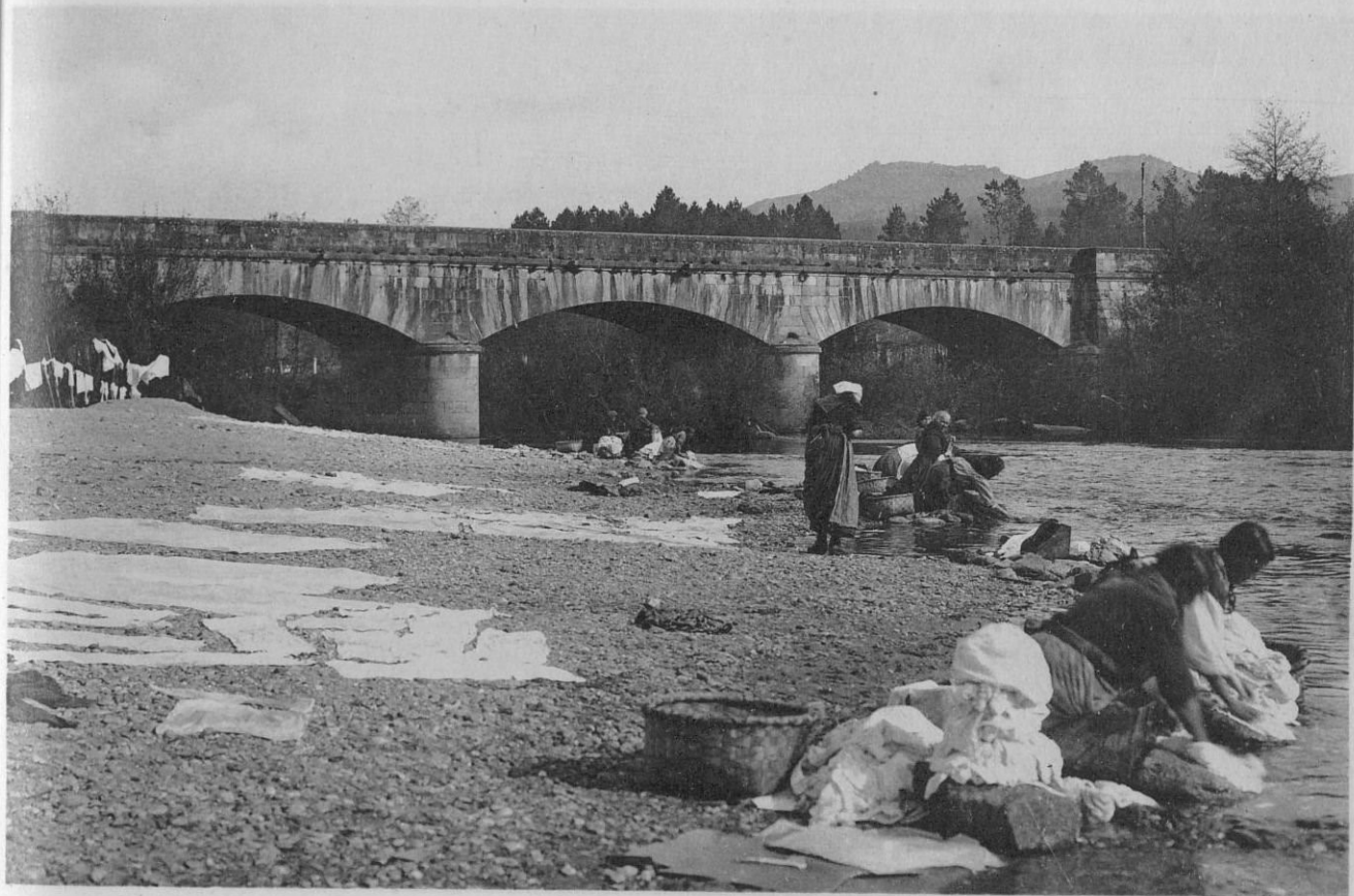
PUENTEAREAS — Puente Nuevo sobre el Rio Tea
