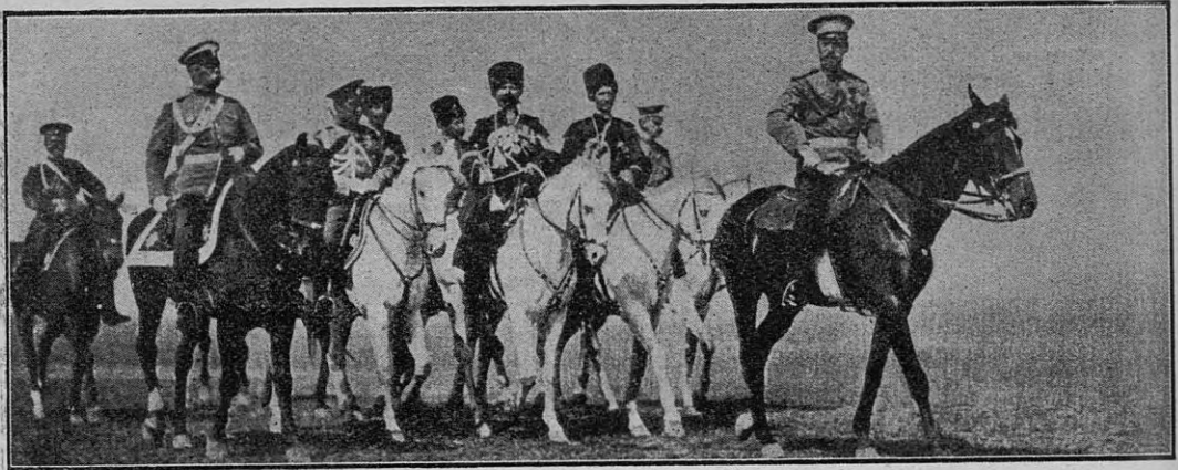
El zar en la llanura de Polonia, seguido de su estado mayor
