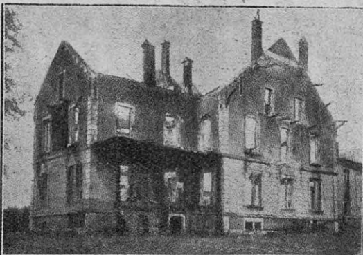
La del general Lyautey, completamente en ruinas
