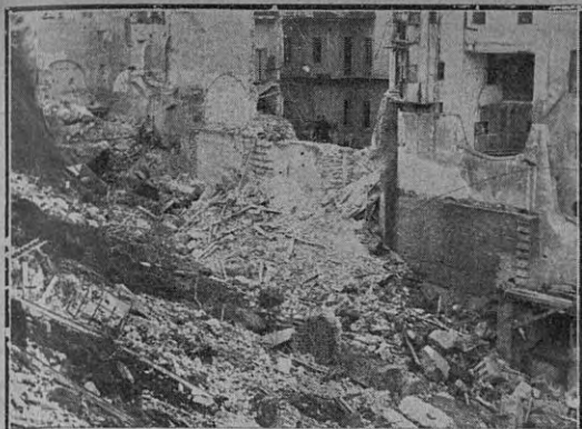
Roma. Hundimiento de un gran edificio en la calle del Tritón
