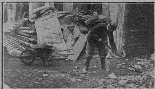
Los hombres removiendo los escombros
