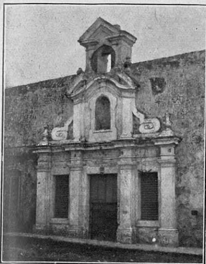
La antigua iglesia convertida actualmente en depósito de materiales
