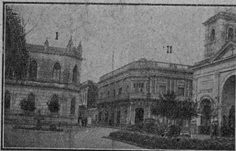
(I) Edificio de la Universidad provincial, por cuya nacionalización se hacen trabajos y (II) palacio del obispado, cuyas autoridades se oponen a la nacionalización por creerla innecesaria
