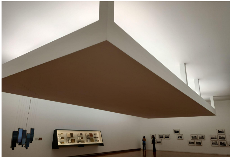
Fig. 24. Sistema de iluminación en forma de mesa invertida en el primer piso del CGAC. Imagen de la autora.
