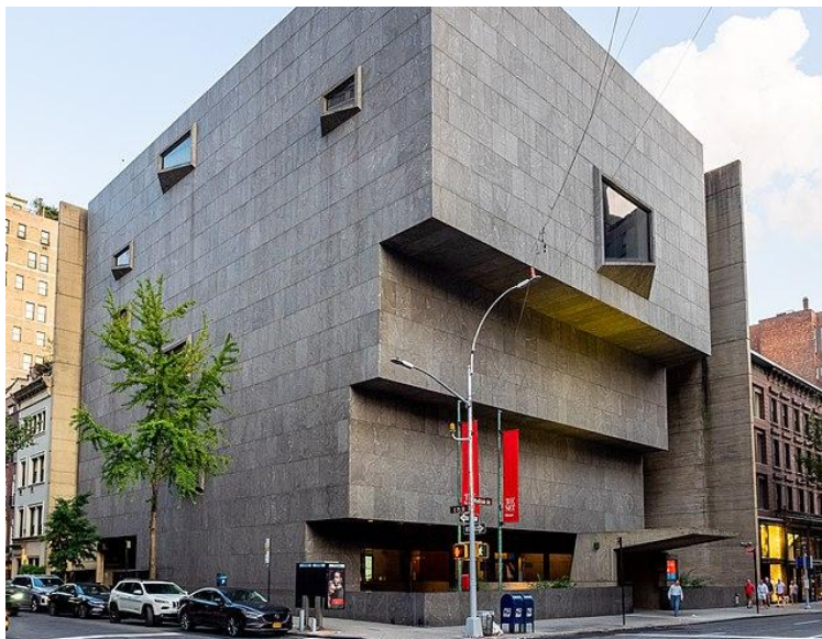
Fig. 6. Breuer Building en Nueva York.
