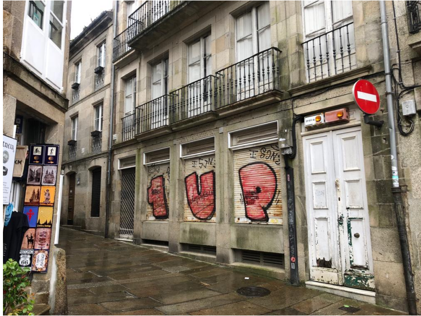
Rúa da Azabachería, 21. Antigo edificio de la Seguridad Social abandonado en el 2009. (Foto del 24/04/2019)
