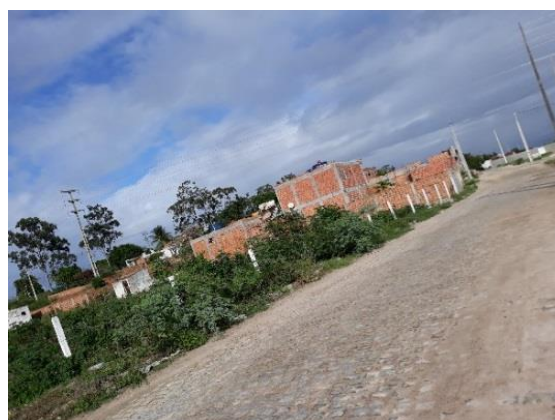
Infraestrutura: calçamento E 499,897 N 8.709,809
