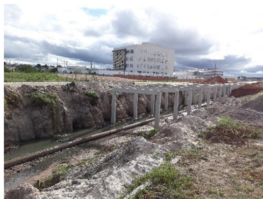
Trecho da drenagem em obra de canalização.
