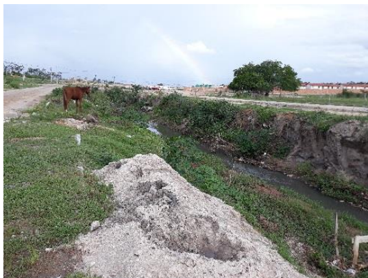
Trecho da drenagem sem canalização.
