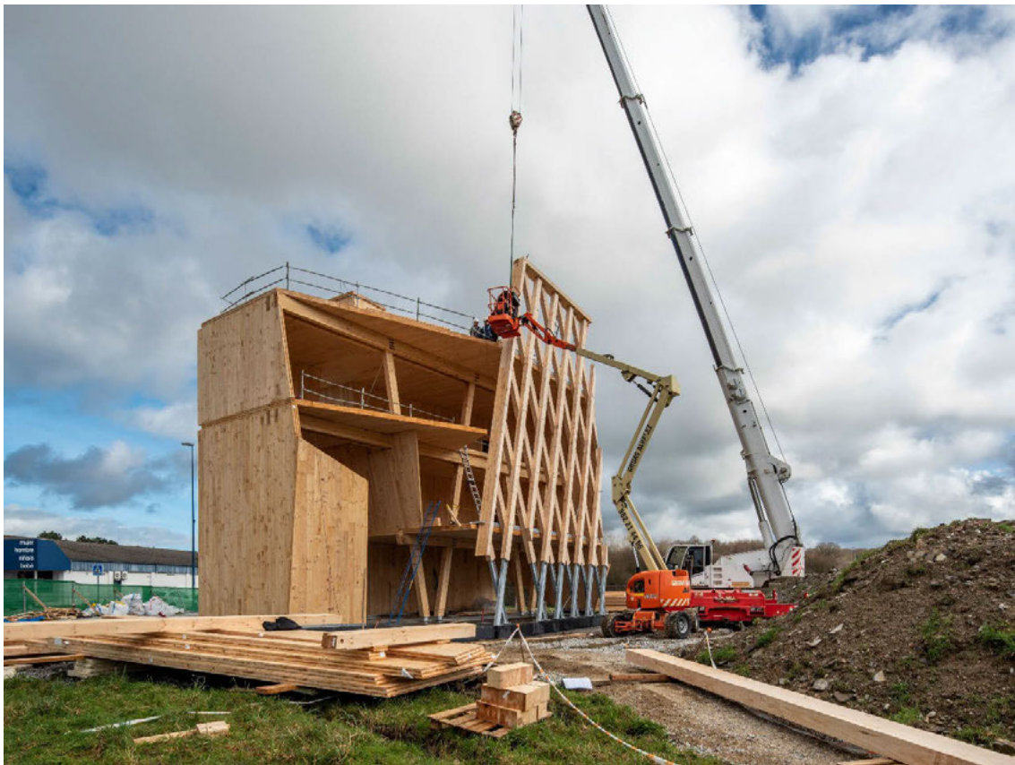
Figura 9. Construcción del edificio Impulso Verde
