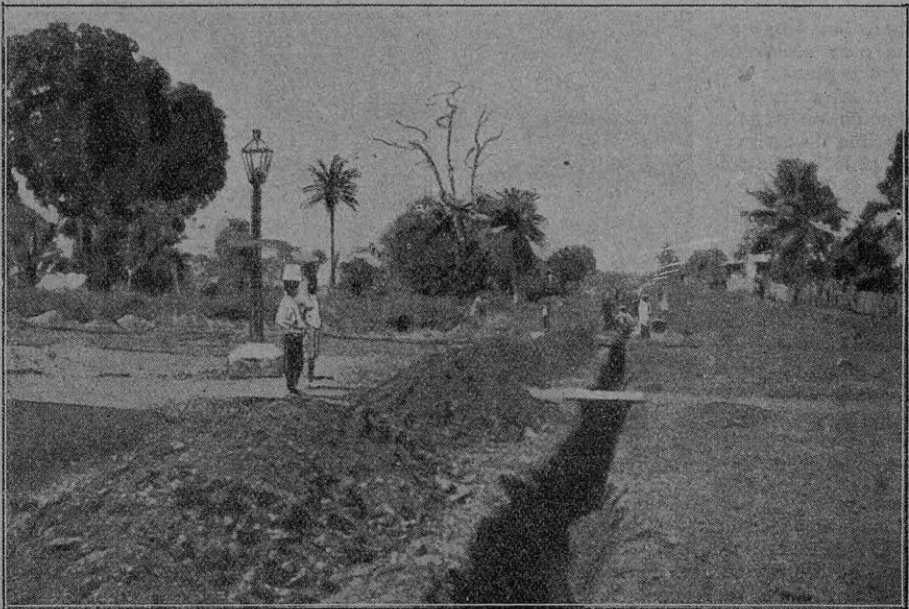
Zanja abierta para tender el cable, en su sección terrestre, en una calle de Monrovia
