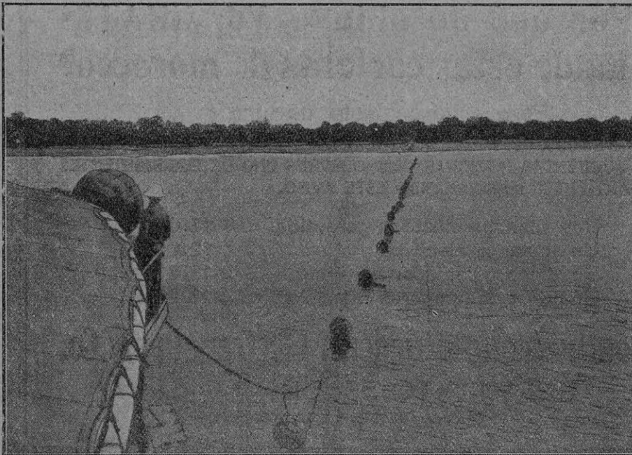
Operación de sujetar el cable en la playa de Monrovia (vista desde el buque cableero)
