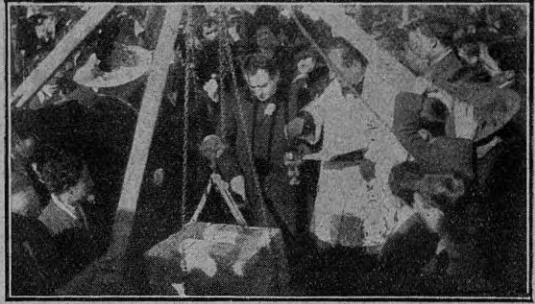
Bendición y colocación de la piedra fundamental del edificio del Círculo de Obreros
