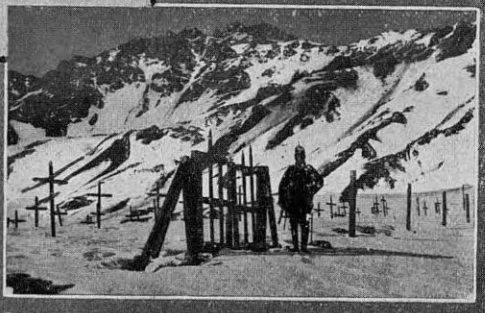
El cementerio, donde habrá unas 120 tumbas, en su mayoría de chilenos muertos de neumonía durante la construcción del túnel. Frente está el cementerio protestante, con unas 40 tumbas
