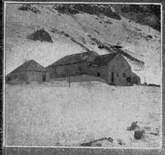
La comisaría, situada a 2 kilómetros de la estación, cerca del túnel
