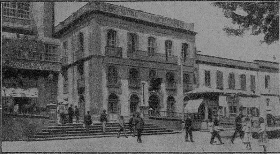
Edificio en que están instaladas las oficinas del cable submarino alemán y del cable español, en Santa Cruz de Tenerife
