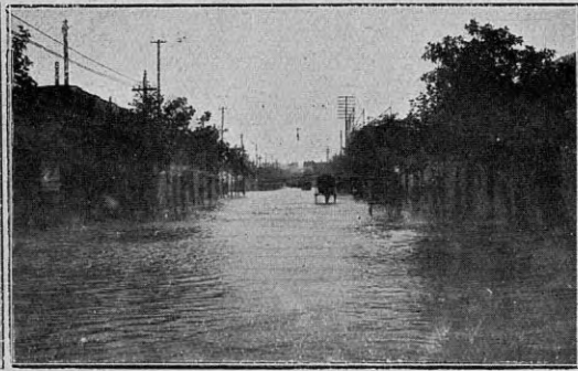
En la estación Goes. Otra vista de la inundación
