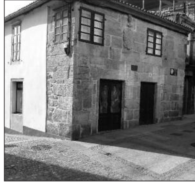
F42. Casa dos Dieste Gonçalves em Rianjo.
