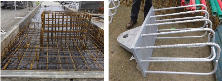
Figura 4.17: Armadura de uno de los muros de reacción (izda.) y pieza de unión con la orejeta de anclaje (dcha.). Imagen propia.
