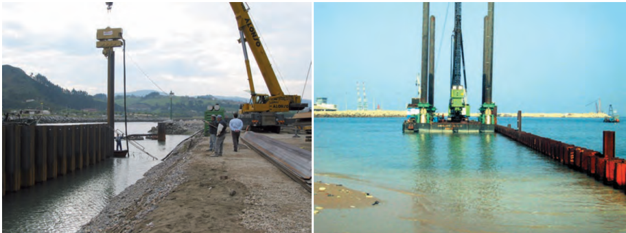
Figura 2.22: Hincado de tablestacas desde plataforma terrestre (izda.) o por medios flotantes (dcha.). Adaptado con permiso de ref. [36]. Copyright, 2009, Puertos del Estado.
