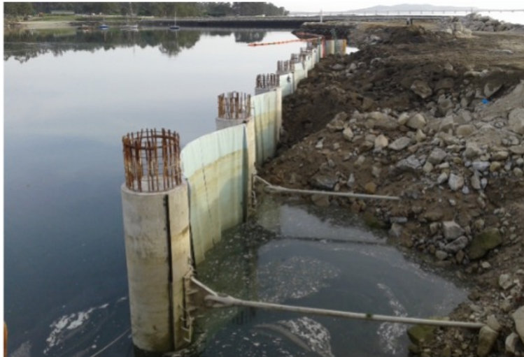
Figura 4.41: Fases iniciales del relleno definitivo. Imagen propia.
