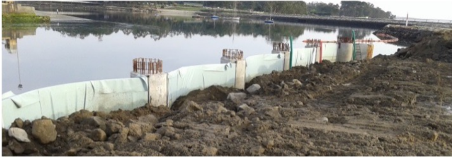
Figura 4.42: Relleno definitivo terminado pendiente de ejecutar su coronación. Imagen propia.
