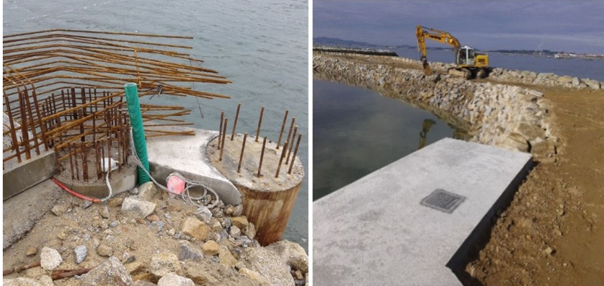
Figura 4.46: Zona de cierre de la viga cantil antes de su hormigonado (izda.) y una vez finalizada su ejecución (dcha.). Imagen propia.
