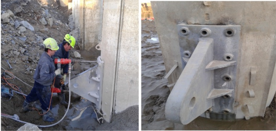
Figura 4.28: Operarios realizando las perforaciones necesarias en un pilote para colocar la orejeta de anclaje (izda.) y detalle de una orejeta tras su colocación en el pilote (dcha.). Imagen propia.
