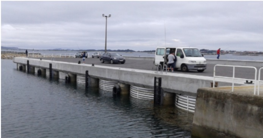
Figura 4.48: Vista frontal general del muelle una vez terminado. Imagen propia.
