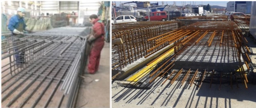
Figura 4.19: Montaje en taller de la armadura de la viga de coronación (izda.) y acopio a pie de obra con la losa inferior hormigonada (dcha.). Imagen propia.
