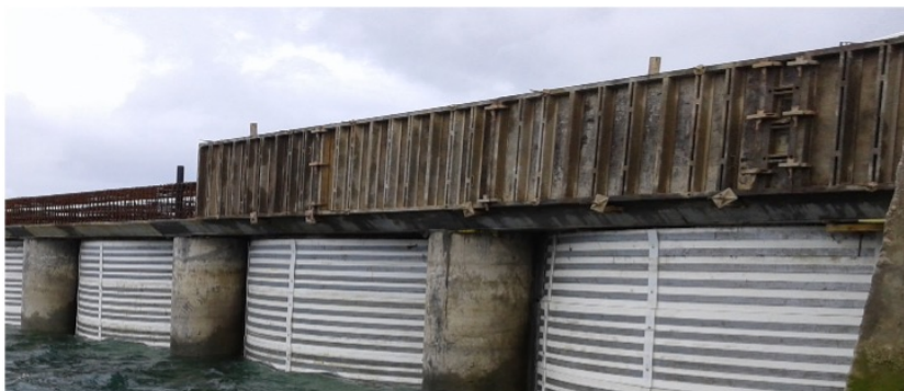
Figura 4.45: Encofrado frontal de la viga cantil en los dos primeros vanos. Imagen propia.
