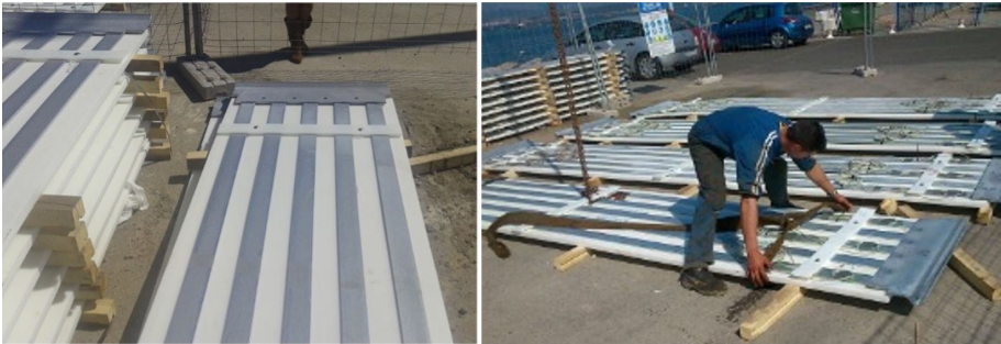
Figura 4.34: Acopio de láminas (izda.) y preparación de las mismas para su izado (dcha.). Imagen propia.
