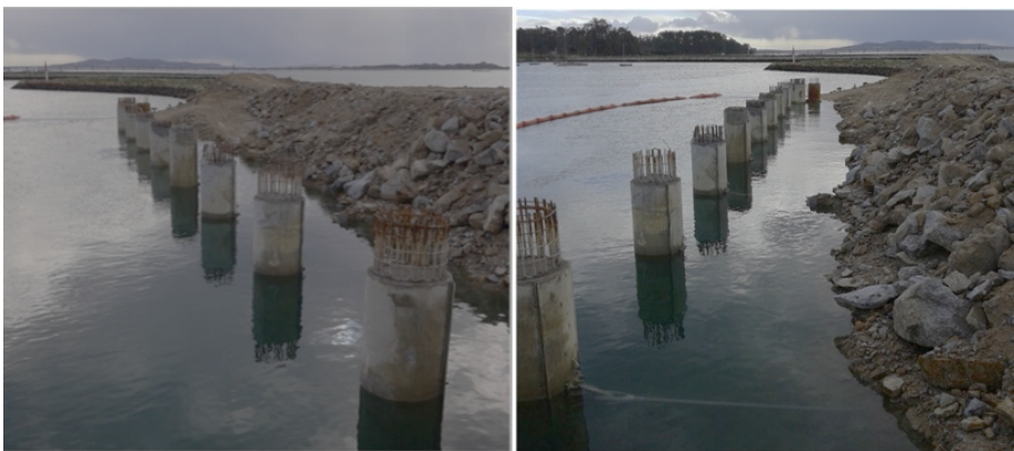
Figura 4.32: Vista desde la parte frontal (izda.) y vista desde la parte posterior de la línea de pilotes (dcha.). Imagen propia.
