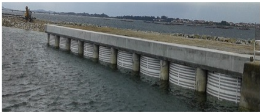
Figura 4.47: Vista frontal de la viga cantil una vez finalizada su ejecución. Imagen propia.
