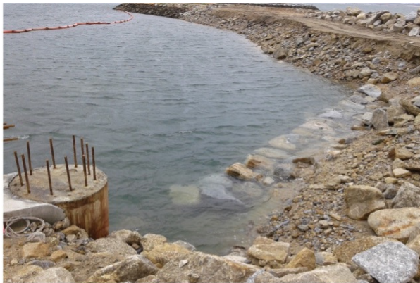
Figura 4.43: Escollera de cierre ejecutada parcialmente. Imagen propia.
