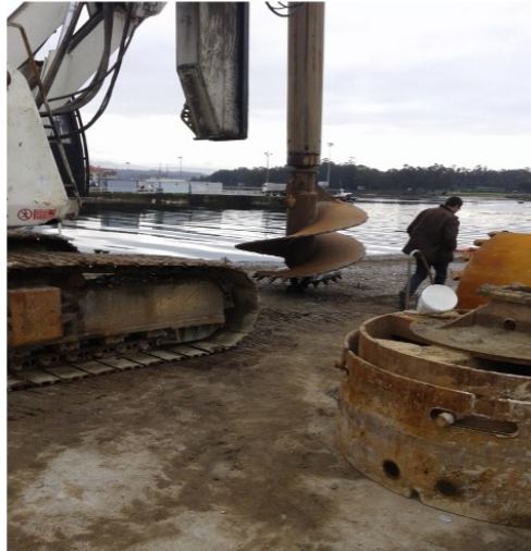
Figura 4.24: Inicio de la perforación de uno de los pilotes. Imagen propia.
