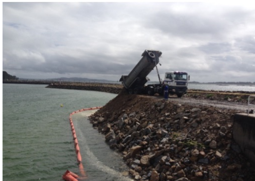
Figura 4.20: Ejecución del relleno provisional. Imagen propia.
