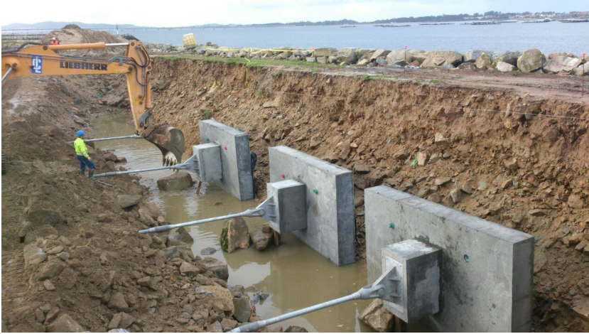
Figura 4.30: Excavación del dique y posicionamiento de los muros de reacción. Imagen propia.
