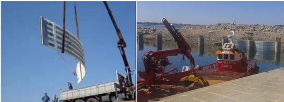
Figura 4.35: Camión grúa (izda.) y embarcación de apoyo empleada en la colocación de las láminas (dcha.). Imagen propia.
