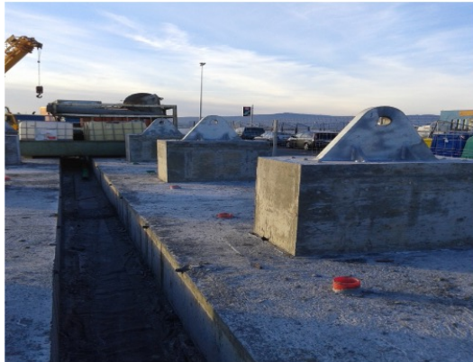
Figura 4.18: Muros de reacción terminados. Imagen propia.
