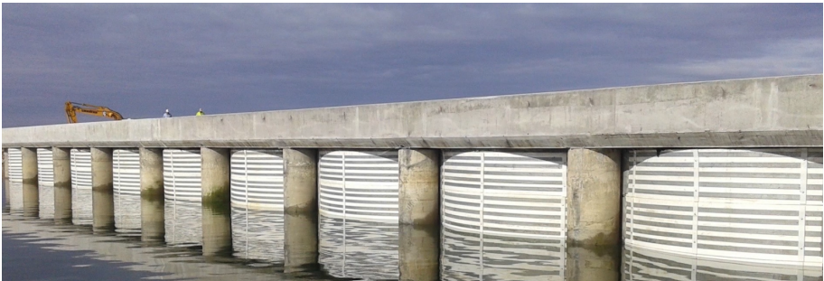
Figura 3.10: Sistema Pilote-Lámina ejecutado en el puerto de Vilanova de Arousa. Imagen propia.
