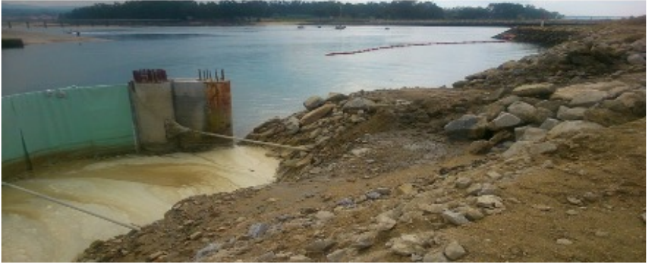
Figura 4.40: Vista posterior de la zona de cierre del último vano. Imagen propia.
