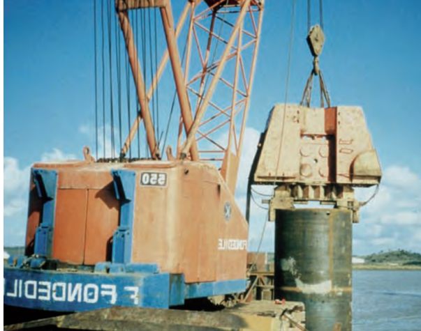
Figura 2.19: Hincado de pilote metálico mediante martillo vibrador Adaptado con permiso de ref. [36]. Copyright, 2009, Puertos del Estado.
