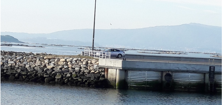
Figura 4.49: Vista frontal de la escollera de cierre del muelle una vez terminado. Imagen propia.
