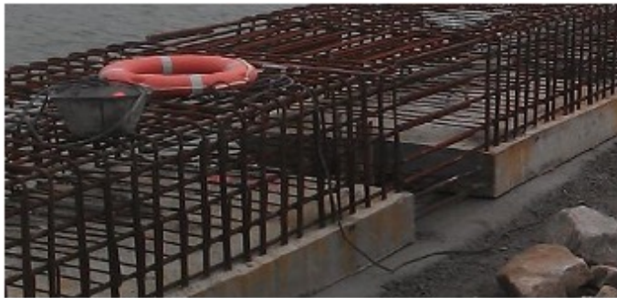
Figura 4.44: Colocación de la armadura de la viga cantil. Imagen propia.
