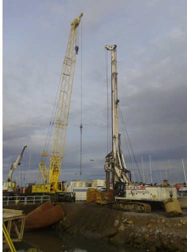
Figura 4.23: Maquinaria para la ejecución de los pilotes. Imagen propia.
