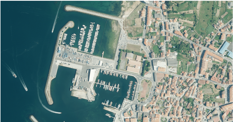
Figura 4.50: Vista aérea del Puerto de Vilanova con el muelle terminado [24]. PNOA cedido por copyright Instituto Geográfico Nacional - Xunta de Galicia.
