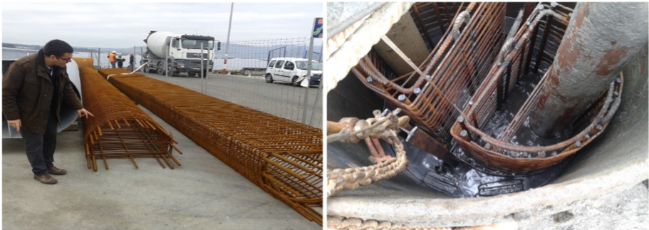
Figura 4.27: Armadura (izda.) y operación de hormigonado de uno de los pilotes de cierre (dcha.). Imagen propia.
