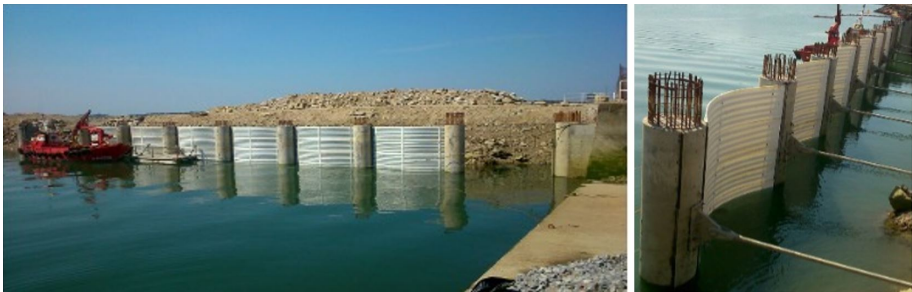
Figura 4.38: Vista frontal (izda.) y vista posterior (dcha.) de la colocación de las láminas en una fase avanzada de su ejecución. Imagen propia.
