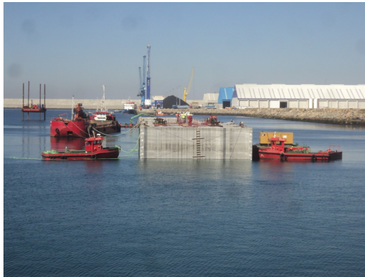
Figura 2.7: Remolque de cajón para su fondeo en su emplazamiento. Imagen propia.
