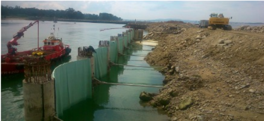
Figura 4.39: Vista posterior del muelle con el geotextil colocado en el trasdós de las láminas. Imagen propia.
