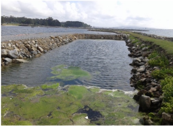
Figura 4.21: Relleno provisional terminado y balsa de agua. Imagen propia.
