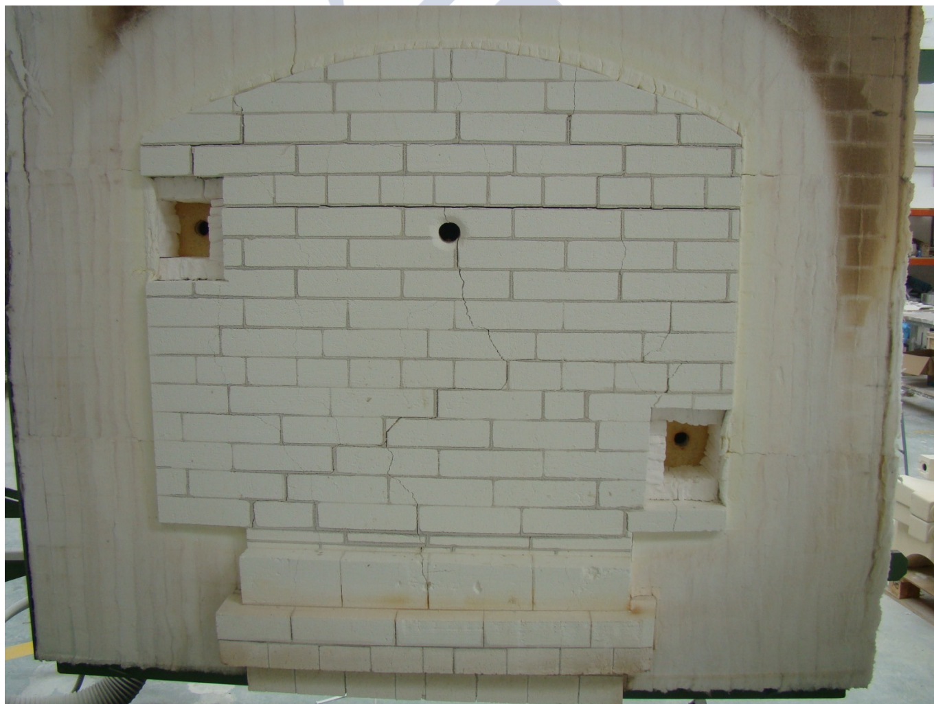
Foto 2 Propagación de macrogrietas grietas en una zona de tensiones térmicas en la puerta de un horno a gas.
