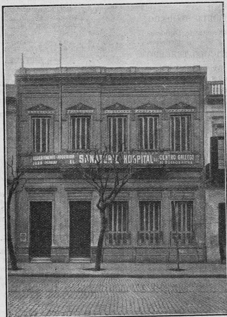
VISTA DEL FRENTE DE LA CASA BELGRANO 2189, DONDE SERÁ CONSTRUIDO EL SANATORIO - HOSPITAL DEL CENTRO GALLEGO
