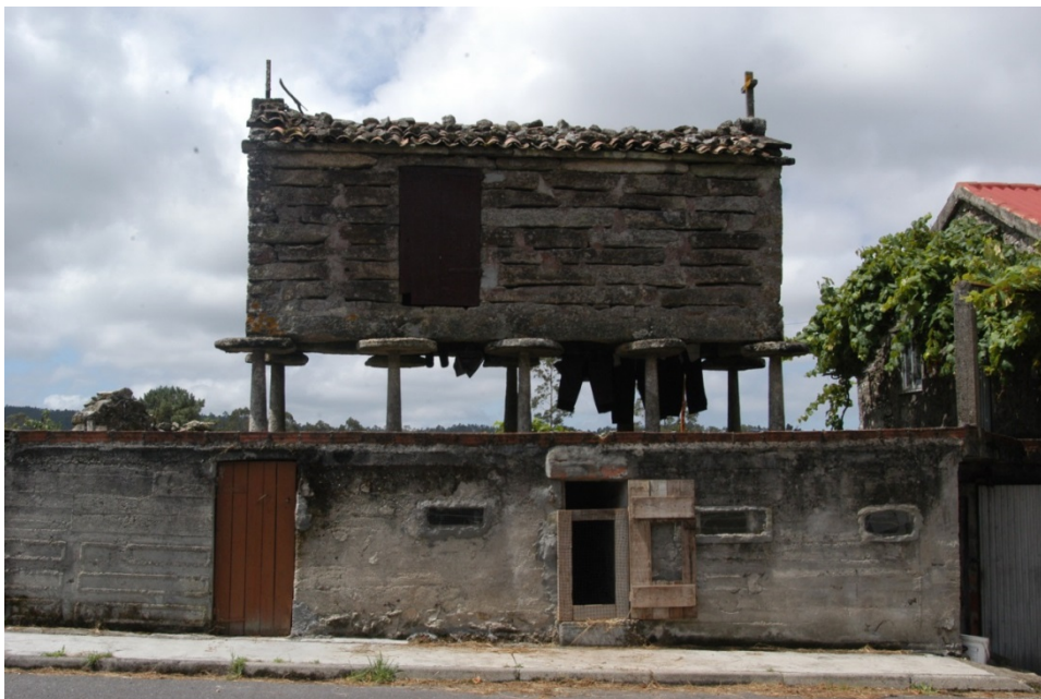
Antigo hórreo situado sobre unha irreverente construción de formigón utilizada como corte.
