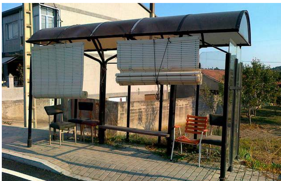
Marquesiña cunha significativa mellora de asentos e incorporación de dispositivos manuais para regular a luz solar (A Veiga, Ourense). Fotografía tomada de "faltadeingenieria.wordpress.com".
