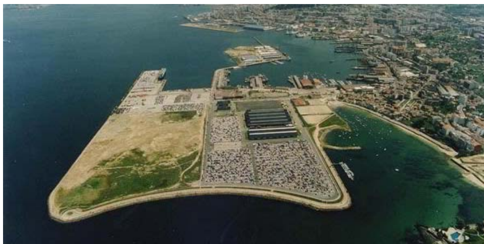
Ano 1999, recheos sobre a Ría de Vigo para a construción do novo porto de Bouzas (Zona Franca, 200.000 m 2 ).
