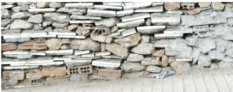
Detalle dun muro na provincia da Coruña.
