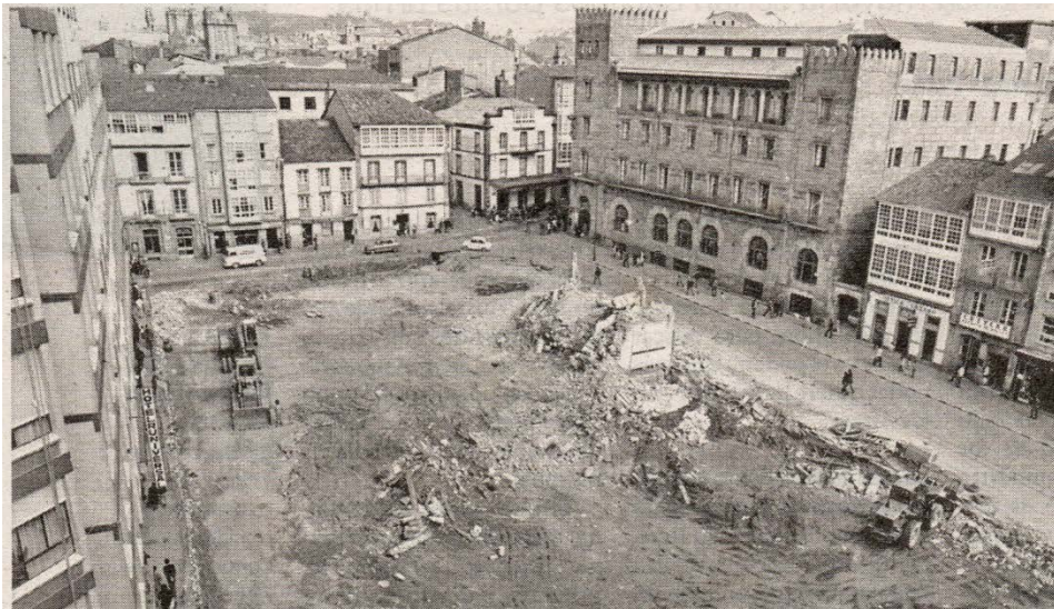
Demolición do edificio Castromil.
