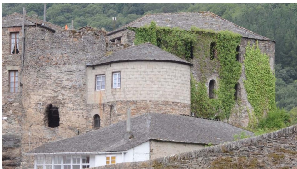
Castelo fortaleza de Navia de Suarna construído inicialmente no Século XI polos Condes de Altamira, e transformada no Século XIV para uso militar. Na parte dereita da imaxe obsérvase os distintos niveis construtivos, o último consistente en bloques de formigón.
