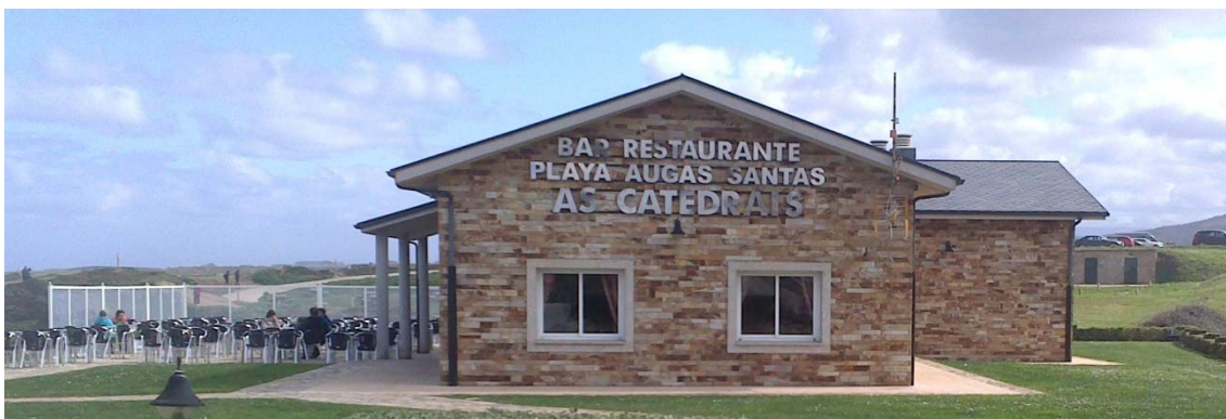
Fig.39. Imaxes do Bar restaurante sito nas inmediacións da Praia das Catedrais, na parroquia da Devesa. Fonte: Imaxes Crecente Asociados.
