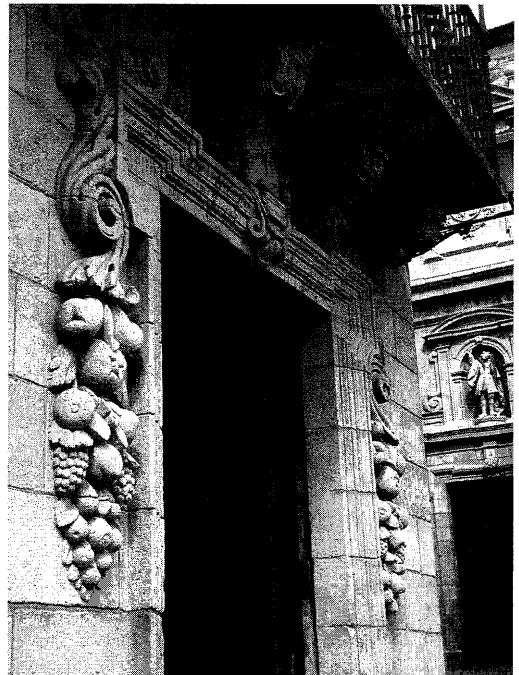
Fig. 27. Sartas y ménsulas decorativas de la casa de la Parra. Domingo de Andrade.
