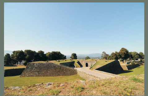
Revelin protexendo unha das portas de Valença
