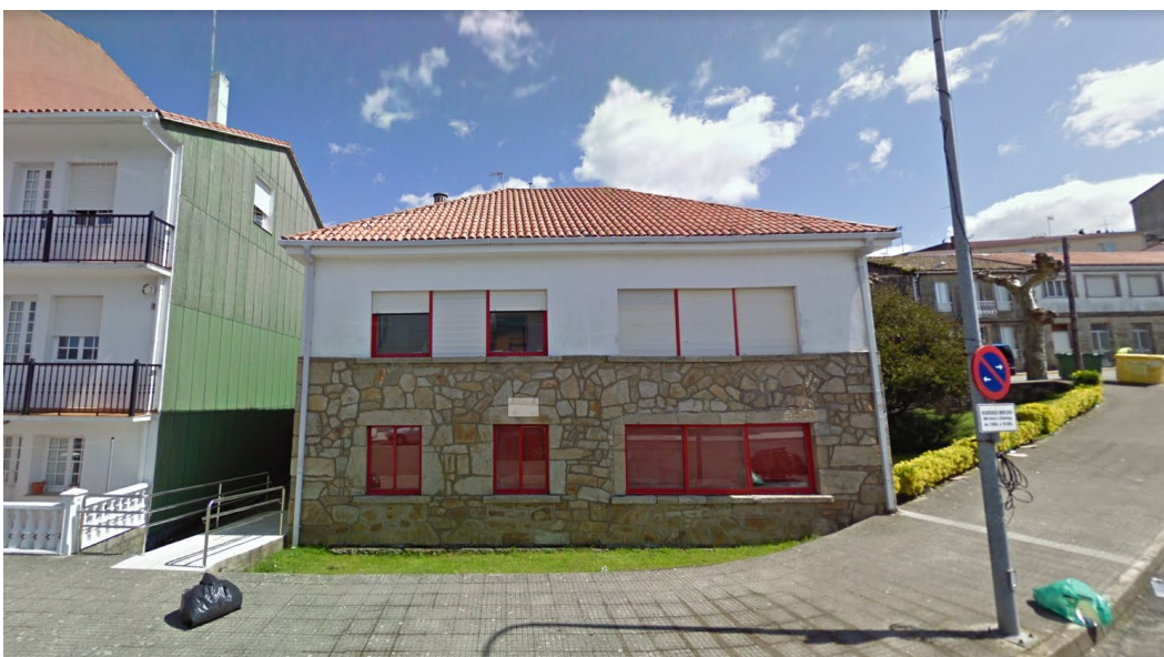
Fig. 17 Fotografía frontal do antigo edificio de Servizos Sociais e as súas dúas plantas, potencial sede do viveiro de empresas. Fotografía tomada de Google Maps
