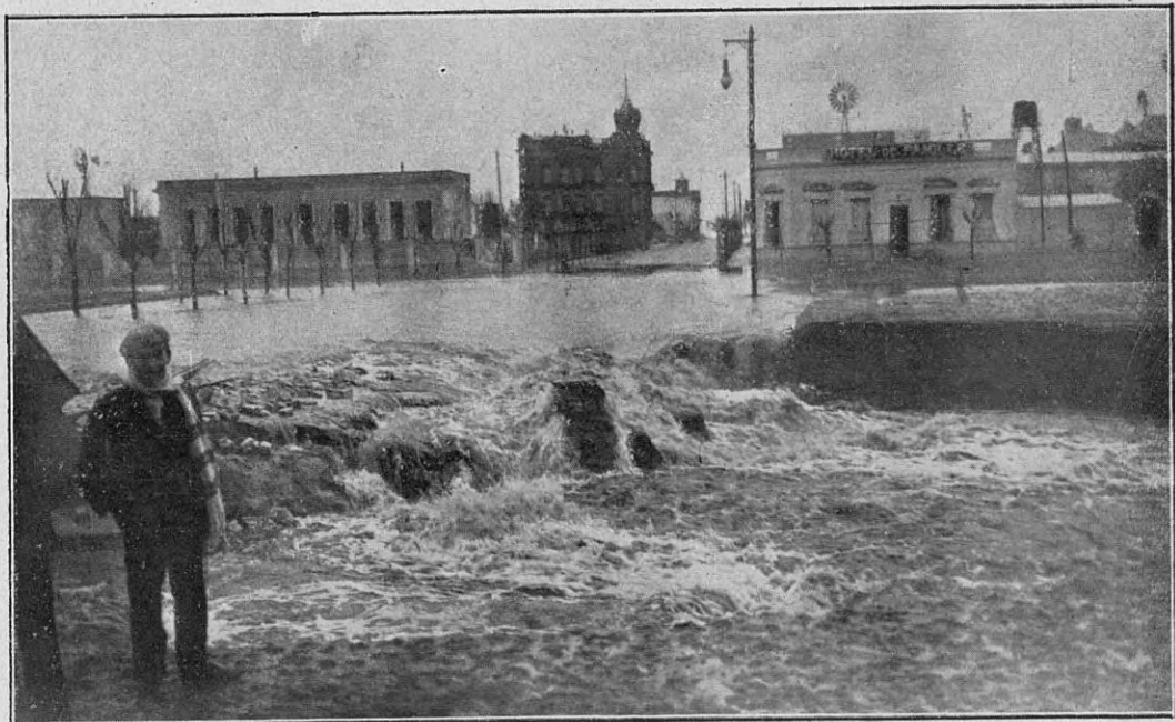
Una de las cascadas que forma el agua de las calles, al desembocar en el arroyo Plaza Luro. (En la calle San Luis)
