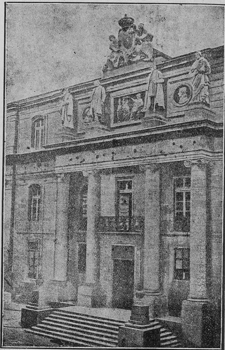
Fachada principal de la Universidad Gallega
