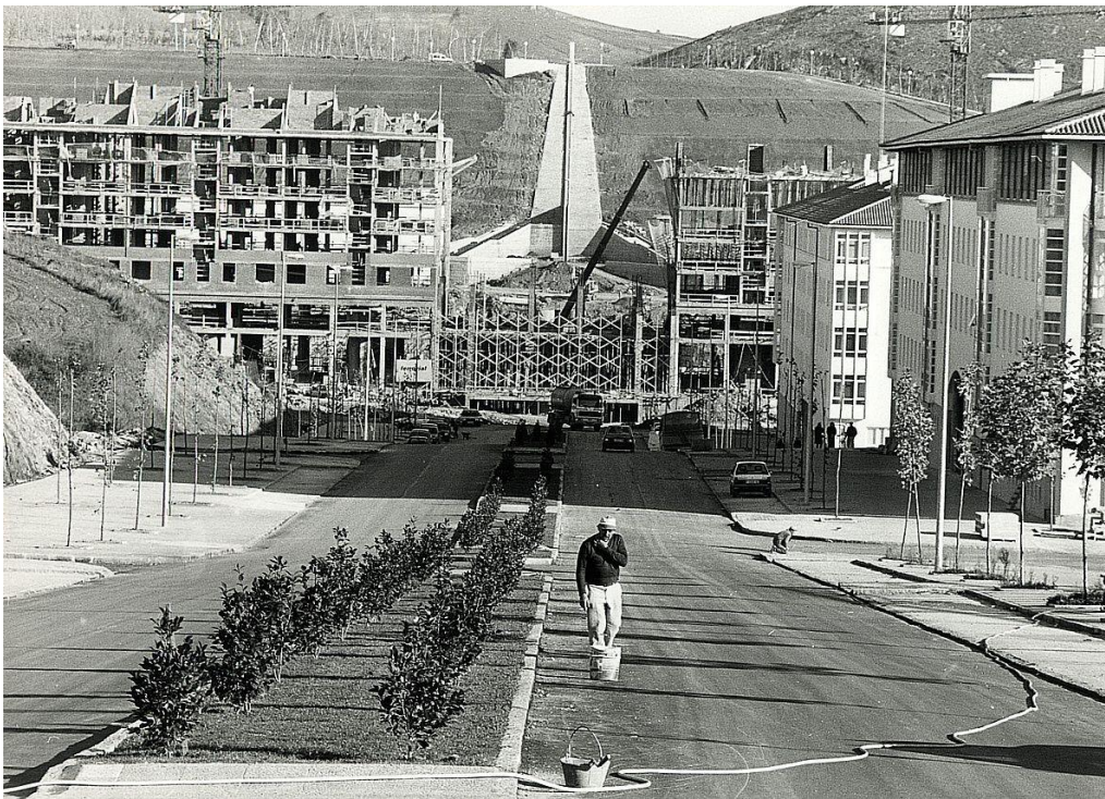
Ilustración 4: CONSTRUCCIÓN DEL CENTRO COMERCIAL.
