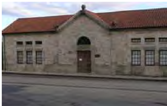
Antiguo edificio del Matadero Municipal
