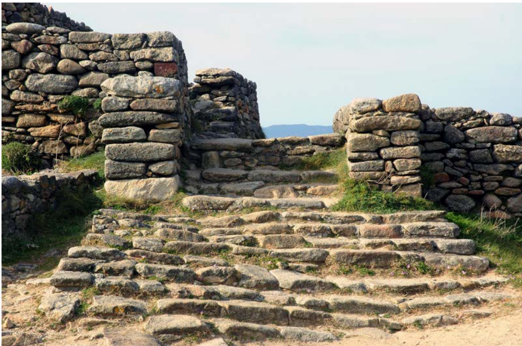
Fig. 4: Escaleiras interiores de Baroña
