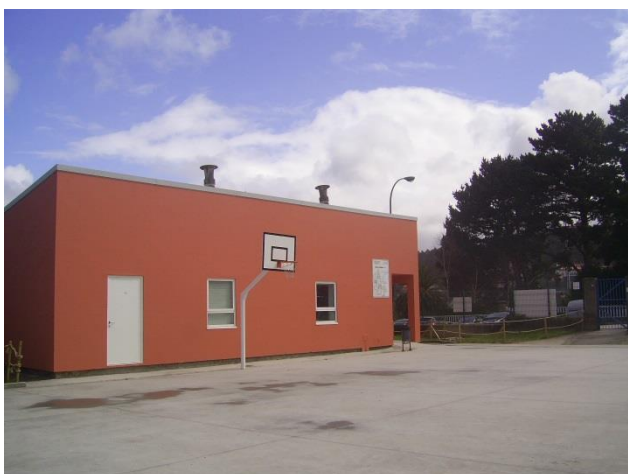
Edificio de conserxería
