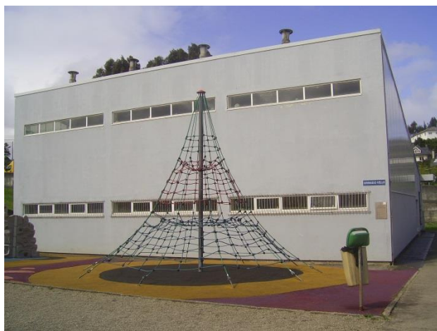
Ao lado do Edificio administrativo atópase unha zona de xogos para 1º e 2º curso. No fondo, obsérvase un pequeno pavillón.
