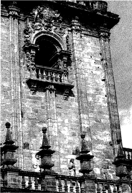
Fig. 1. Detalle de la torre del Reloj hacia la Quintana.
