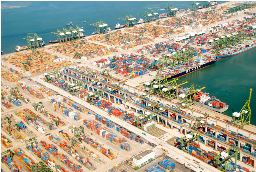
Figura 5.23: Sistema OBHC na terminal do Porto de Singapur
