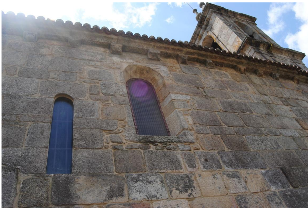
Imagen 62: vanos muro sur
