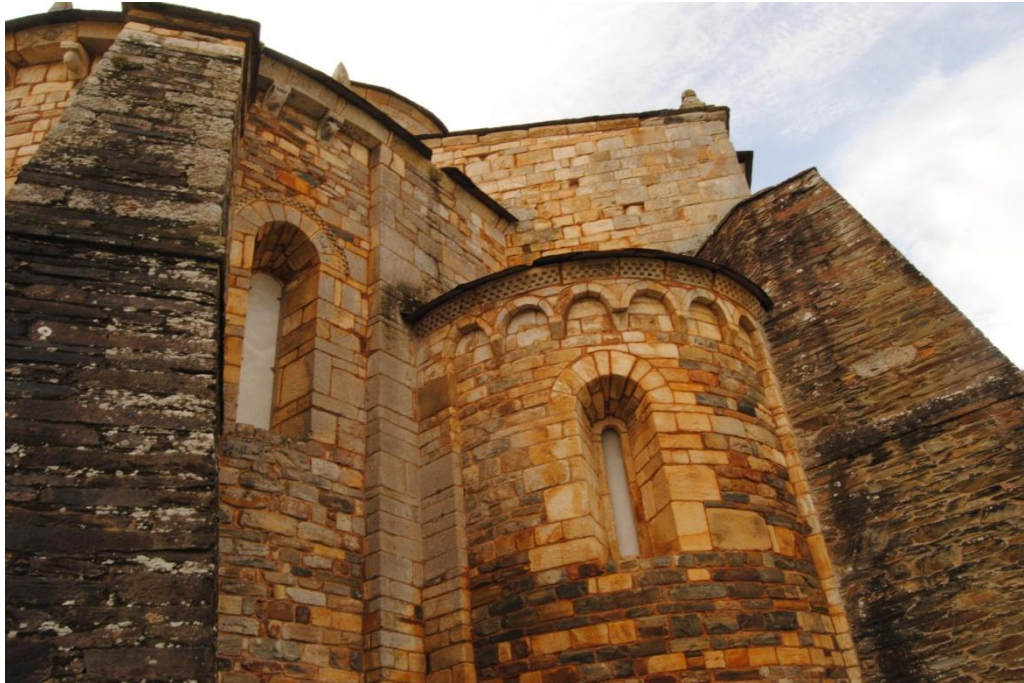
Imagen 2: ábside norte (exterior)
