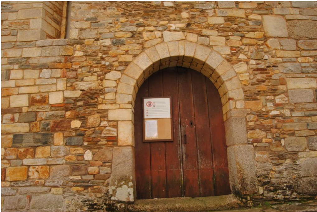
Imagen 10: puerta muro norte
