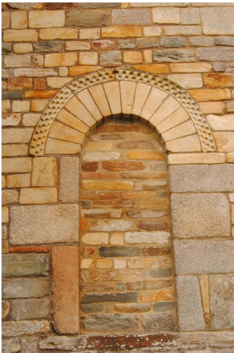
Imagen 8: vano cegado muro norte
