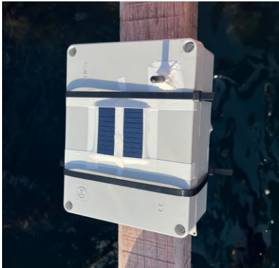
(a) Sistema final en batea de cerca.
