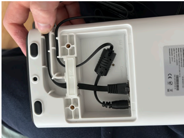
(a) Instalación de cables de red y alimentación en el gateway.
