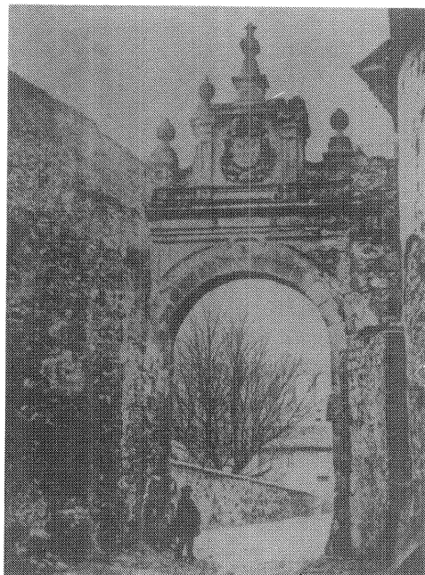
Puerta de San Juan (cara interior). Segovia.
