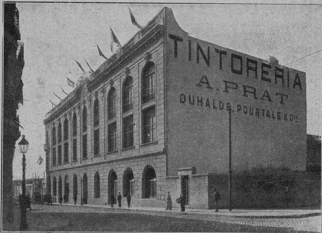
Edificio de la usina, talleres y administración de la gran "Tintorería A. Prat", de los señores Duhalde, Pourtalé y Cía., Montevideo, 1917 al 1947
