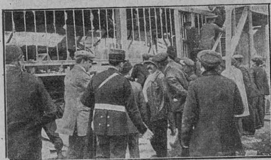
Después de la explosión. El público examinando el garage
