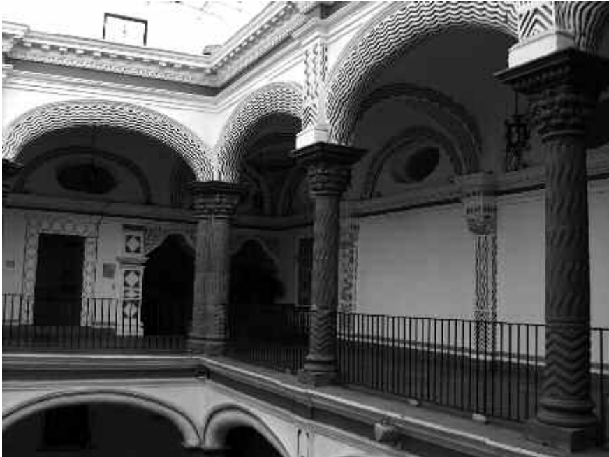
Fig. 8. Casa de las Bóvedas, ciudad de Puebla. Patio. Segundo piso. Foto: Martha Fernández.
