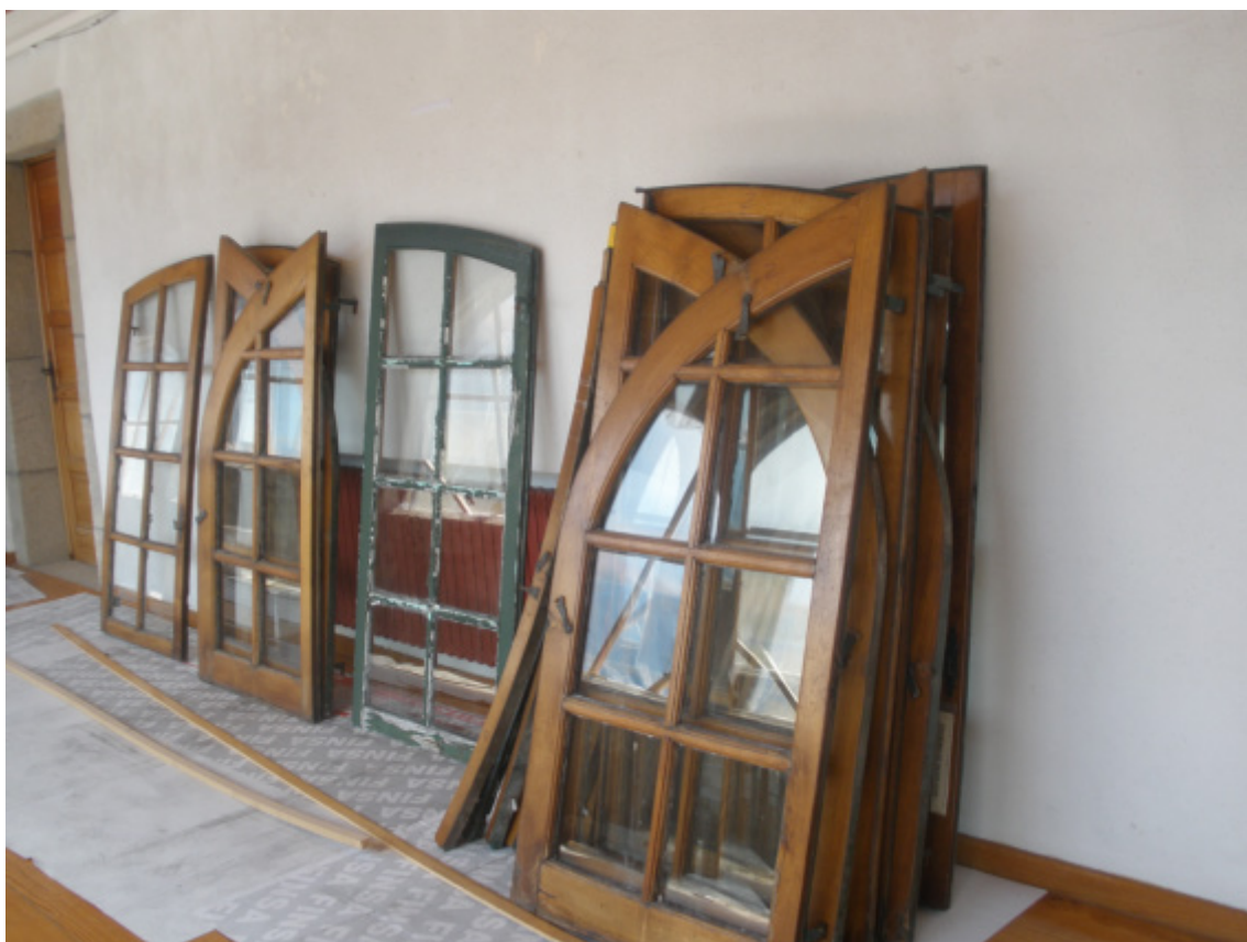
Estado da carpintería antes das obras
