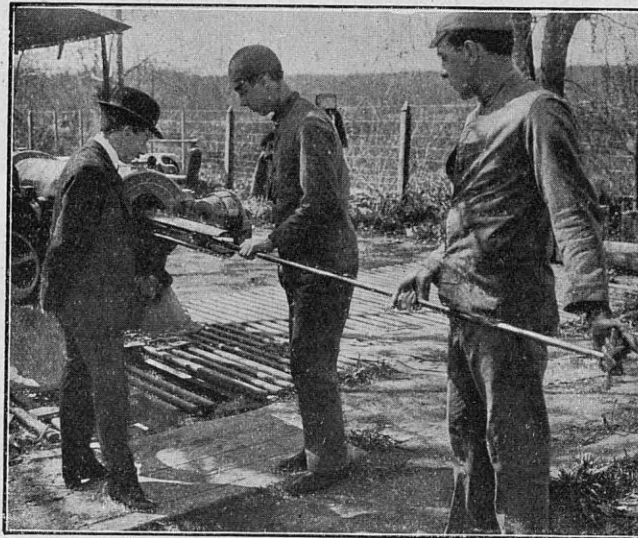
La estampa del ánima de un cañón de 120 A. T. R. — Una inspección minuciosa de una estampa de gutapercha sacada del ánima, pone en evidencia el estado actual de la pieza
