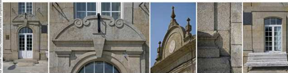
Detalles da fachada principal
