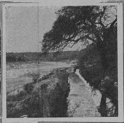
Toma de agua de un canal de riego
