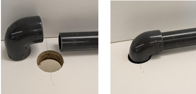
Figura 11. Izquierda: perforación para conexión con elementos inferiores. Derecha: resultado final colocado.
