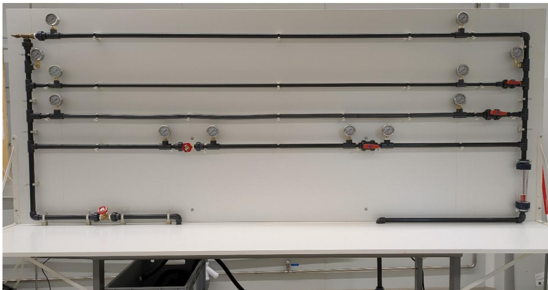
Figura 15. Colocación final de los elementos hidráulicos.
