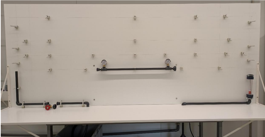
Figura 16. Encolado de la línea inferior.
