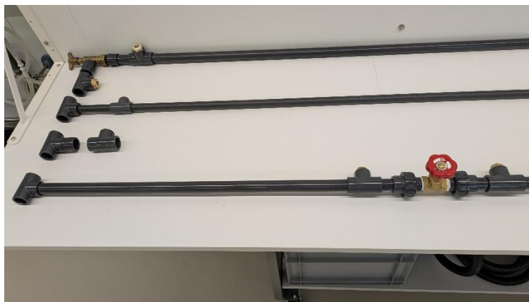
Figura 8. Colocación previa al encolado de los elementos de las líneas horizontales.
