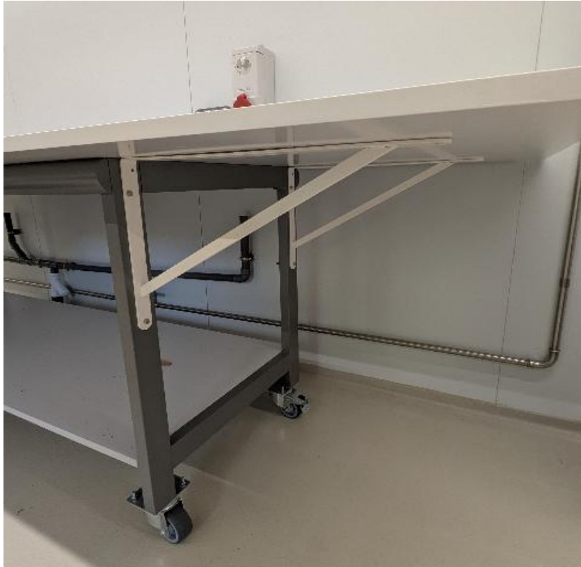
Figura 1. Anclaje del tablero base a la estructura metálica mediante escuadras.
