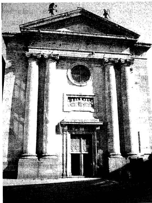
Fig. 1. Fachada. Capilla General de Ánimas. Santiago.
