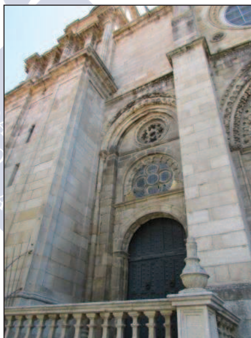
Fig. 9: Torre septentrional. Fachada occidental. Catedral de Ourense.
