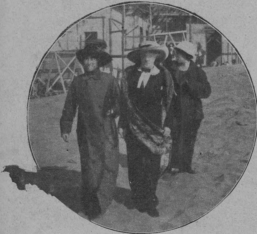
Damas visitando las obras
