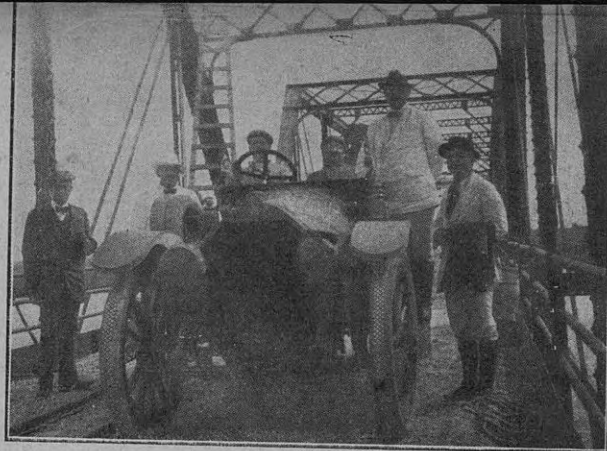
Puente sobre el Samborombón
