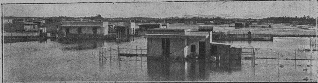
Vista parcial de Villa Obrera inundada. El agua alcanzó hasta 1 metro 30 de altura
