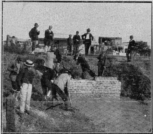
Ensanchando otra alcantarilla
