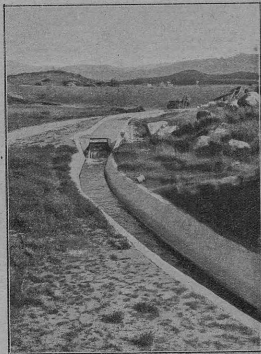
Canal de riego, revestido con hormigón para disminuir la pérdida ocasionada por la filtración
