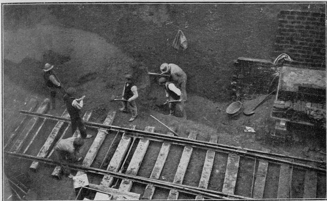
Bajo tierra.—Abriendo el túnel á golpes de piqueta
