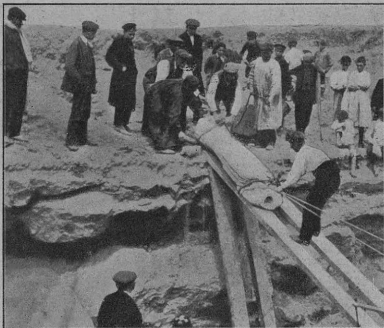
Trabajos para la extracción de la estatua
