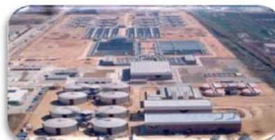
E.D.A.R. Baix Llobregat (Barcelona) Caudal: 420.000 m 3 /d
