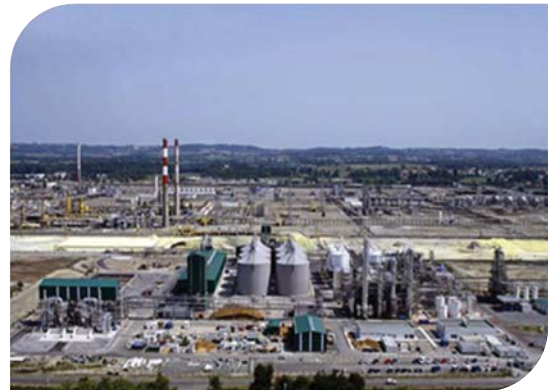
Suministro del centro de monitorización y control para la planta de Lacq.
