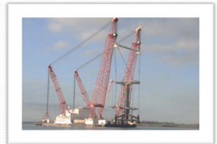
Instalación Seagen en el Canal de la Mancha
