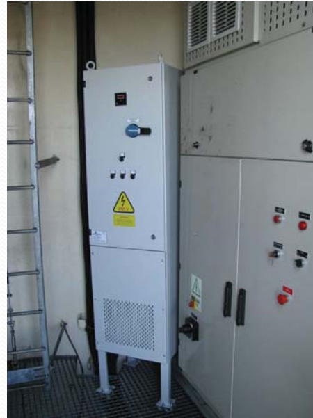
FASE DE INSTALACION
