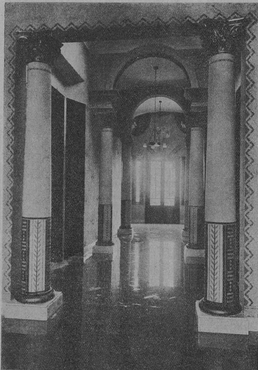
HALL DEL 2.º PISO
