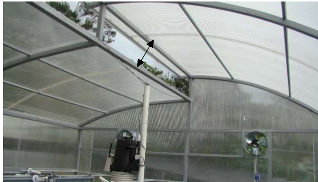
Figura 2. En el invernadero se aprecia en la parte superior mediante flechas una apertura (ventana cenital) para salida de aire caliente y evitar excesos de temperatura
