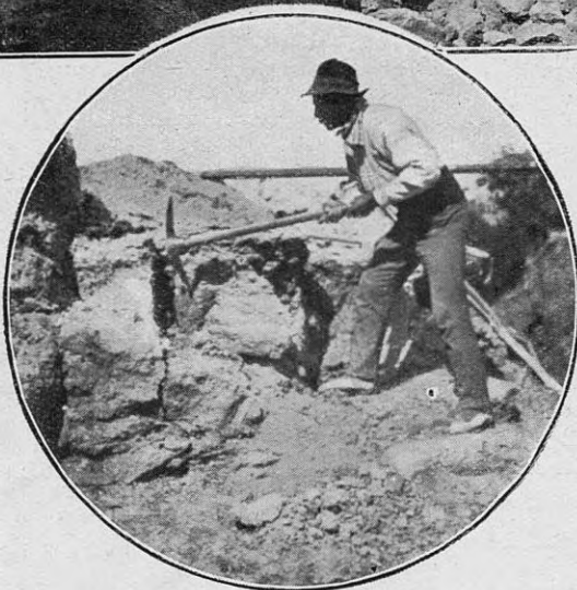
Separando los grandes trozos de piedra
