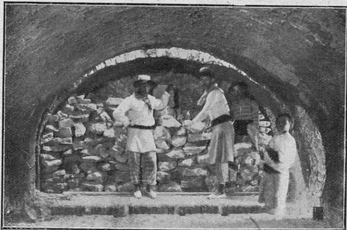
Interior del horno, sistema Serrano
