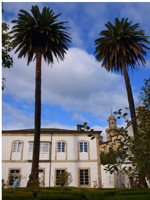
Figura 136: Palmeiras Canarias da Casa de Oia
