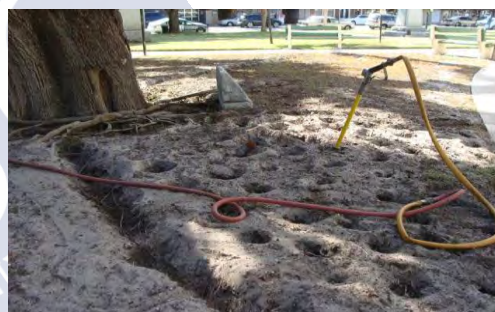
Figura 50: Descompactación mediante orificios verticais de 3-4 cm de diámetro e entre 30 e 40 de profundidade que se reenchén con perlita, vermiculita ou outro material de emenda (Fotografía tomada de https://shadetreexpert.com/2013/wp-content/uploads/2013/01/DSC04608.jpg )
