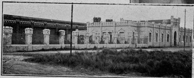
Vista parcial de la cárcel
