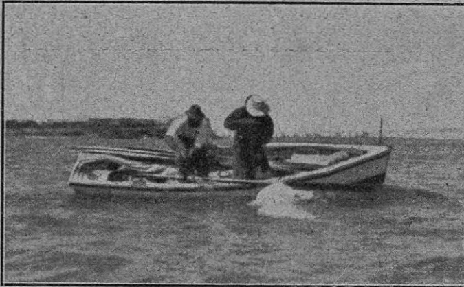
Arrancando los dientes a la presa
