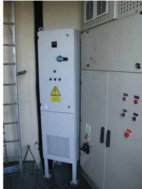
FASE DE INSTALACION
